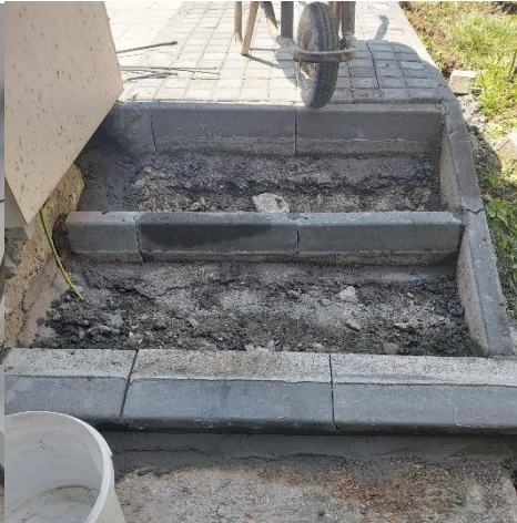
T3.5 Merdiven Yapımı
