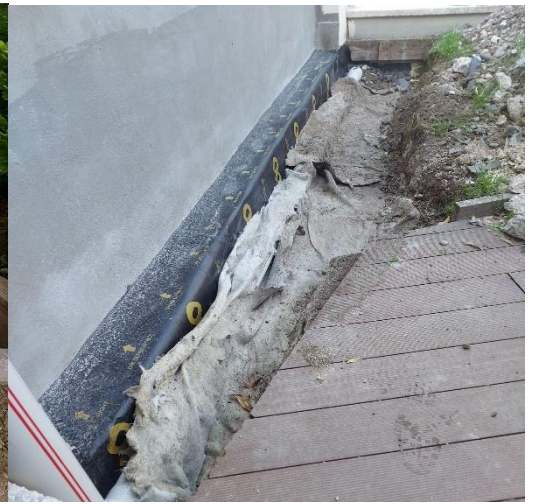
T2.14 Bahçe Katı Su Yalıtımı Çalışması
