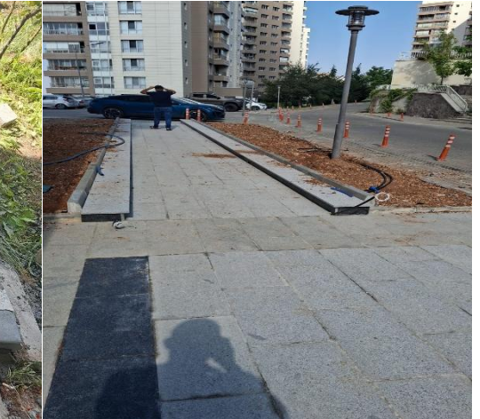
T1.2 Granit Yaya Yolu Yapımı
