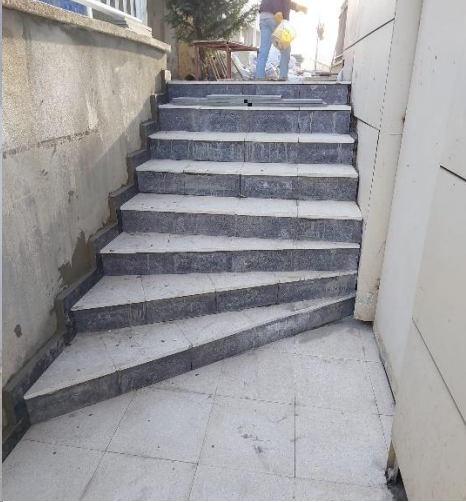
T2.13 Yangın Kapısı Merdiven Yapımı
