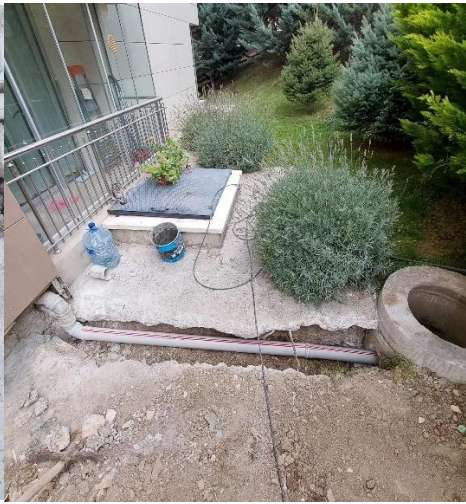
T2.13 Yağmur Borusu Bağlantısı
