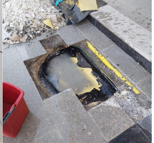
T2.14 Blok Önü Gider Çalışması
