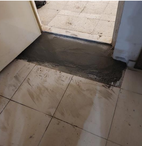
T3.2 Garaj Çıkışına Rampa Yapımı
