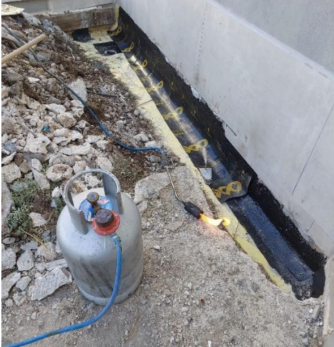
T2.12 Blok Su Yalıtımı Çalışması
